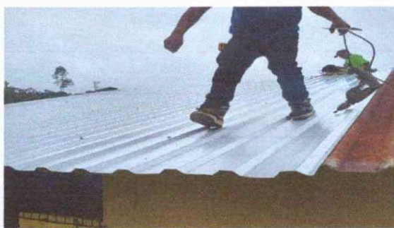
Foto 2: Instalacion de las laminas troqueladas.
