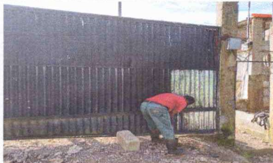
Foto 4: Mantenimiento del porton y aplicación de pintura.
