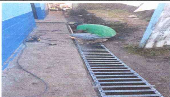
Foto 5: sustitución de la parrilla de las cunetas.
