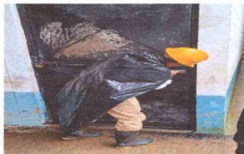
Foto 6: mantenimiento de las puertas
