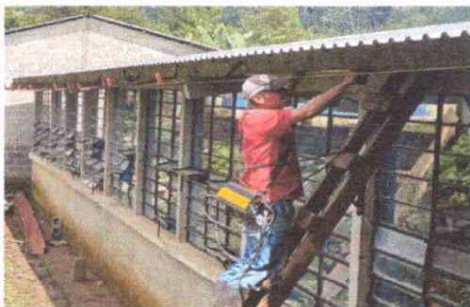
Foto 3: Colocación de los pescantes para canales de metal.
